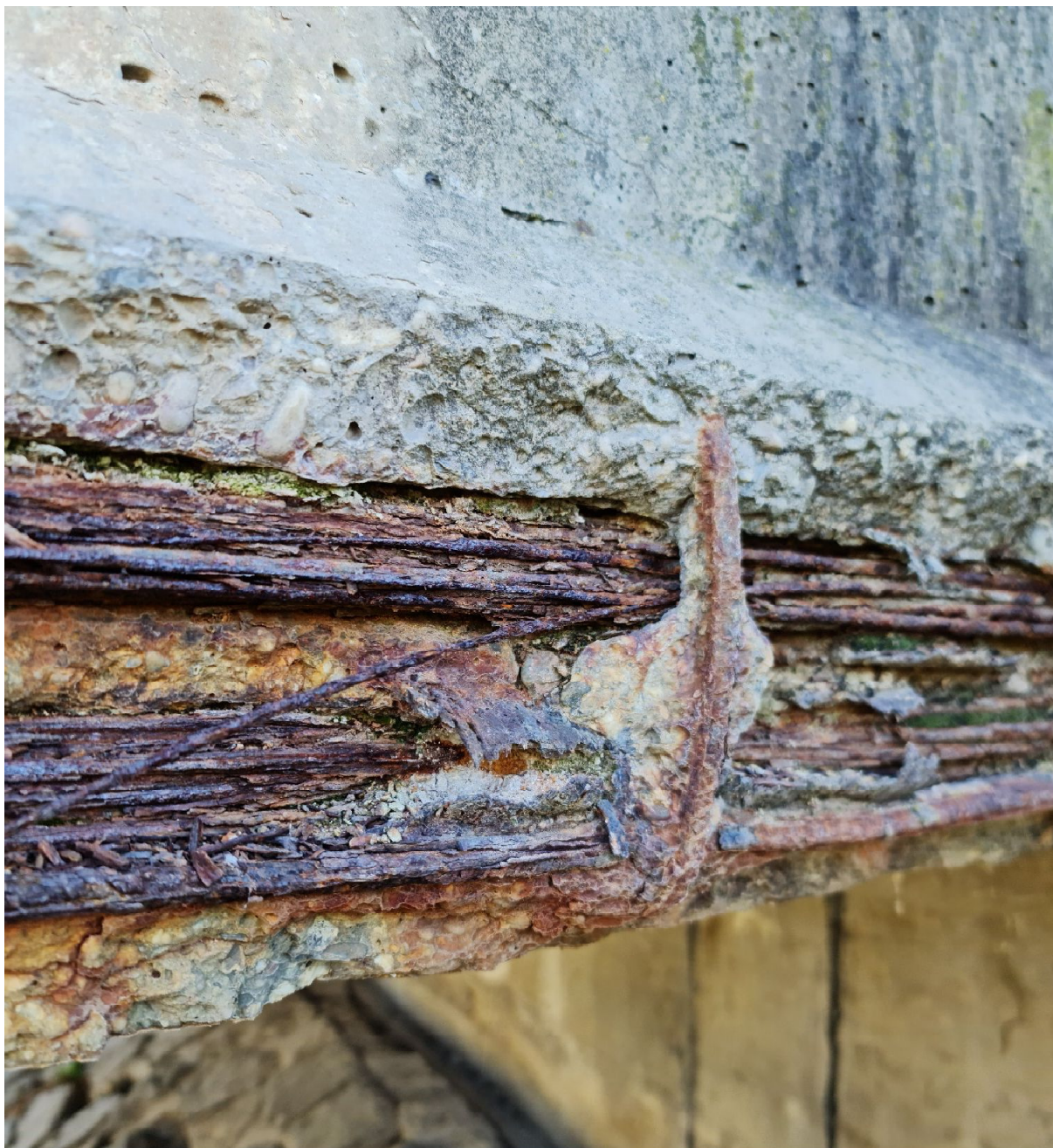
Obrázok 16: Porucha predpínacích káblov krajného nosníka
