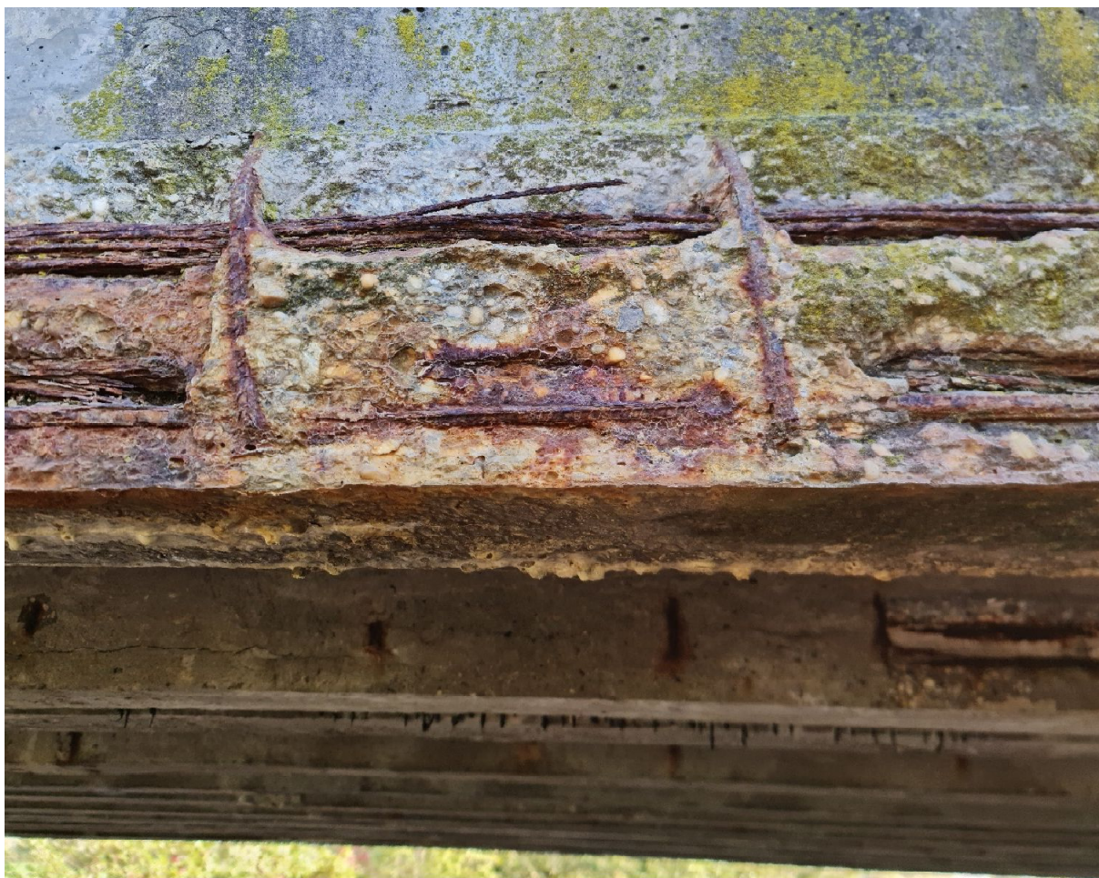
Obrázok 18: Pretrhnutý drôt v hornom kábli
