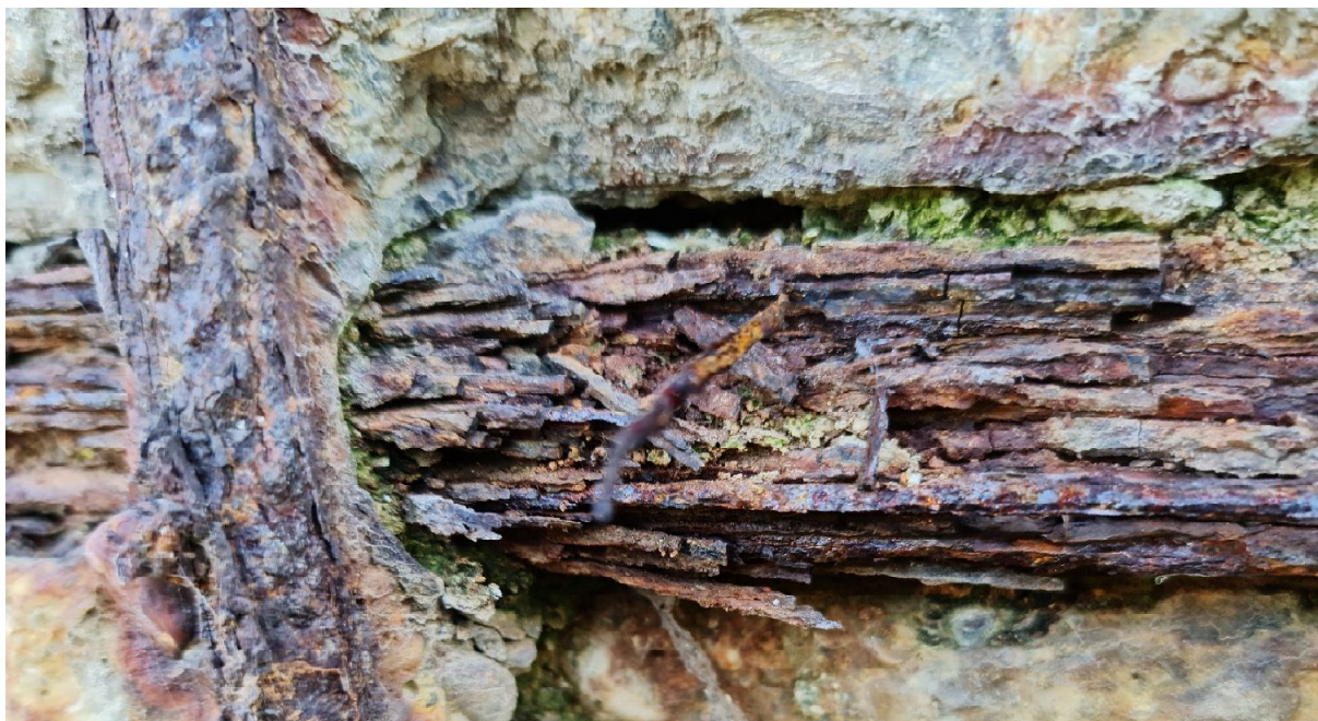
Obrázok 17: Miera korózie predpínacích drôtov
